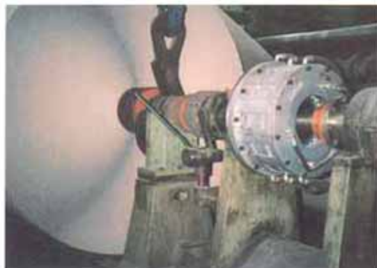
Переоборудование намоточного станка Bruderhaus с тормозом CSM 221
